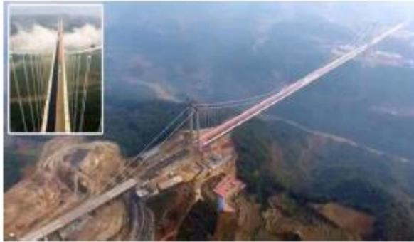
El puente está suspendido a 300 metros de altura, y tiene 32 metros de ancho, 167 metros de alto y dos kilómetros de largo, convirtiéndose en la estructura más larga del mundo de sus características. Ha costado mil millones y medio de euros y se trata solo de la primera gran obra que China pretende realizar en la región de Yunnan ya que se encuentra en pleno proceso de construcción un segundo puente.
